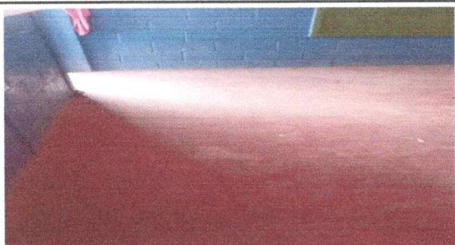
Foto 5: 6.8 Sustitución de piso cerámico. Módulo 2.
