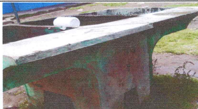
Foto 8: 19.2 Cambio de pila
