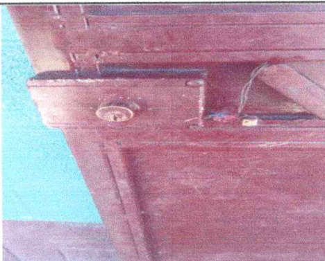
Foto 3: 4.2 Sustitución de chapa en módulo 1.
