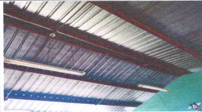
Foto 2: 2.1. Mantenimiento a estructura de soporte de metal. Lijado y pintado. En módulo 1.
