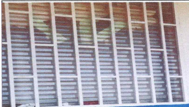
Foto 4: 5.6 Sustitución de balcones de metal en módulo 1.
